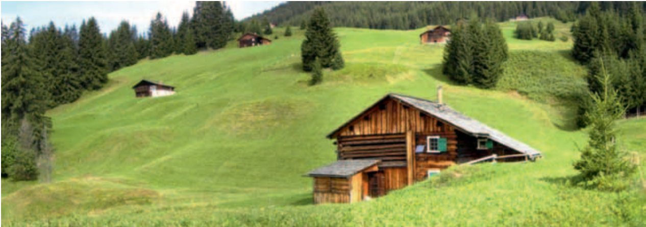
Abb. 2: Panoramaaufnahme westlich der Knappagruaba. Links von der Hütte sind die Halden zu erkennen. Rechts knapp oberhalb der Hütte ist ein verstärzter Stollenzug zu erkennen.
