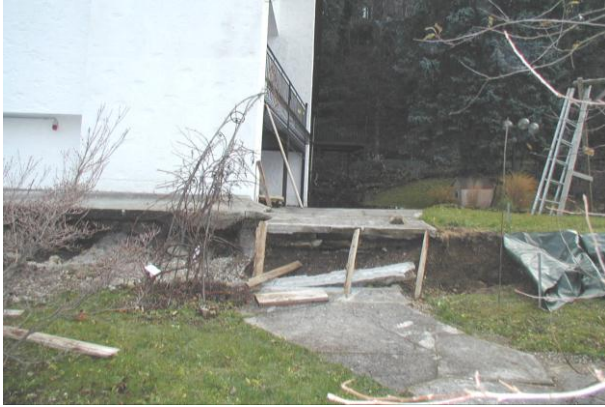
Anbruchbereich; In der Bildmitte erkennbar der Versatz im Bereich des Gartenweges und der
