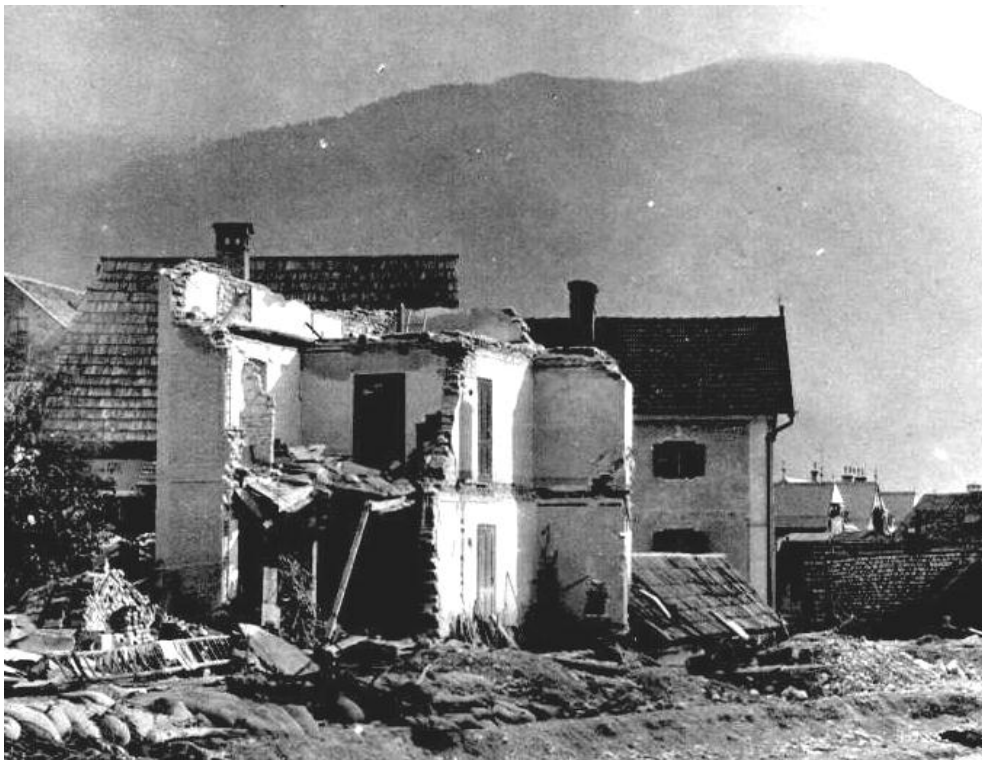
Abb. 2: Ein durch die ankommenden Wassermassen des Langbathbaches total zerstörtes Wohnhaus (Reisenbichlerhaus) aus dem Jahre 1899.
