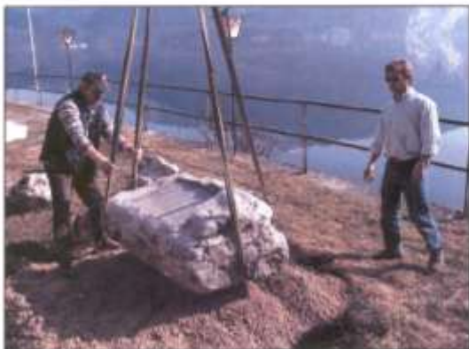
Abb. 5: Versetzen der Blöcke mit Hilfe von Gurten in Lueg (links) und an der Seepromenade in St. Gilgen (rechts)
