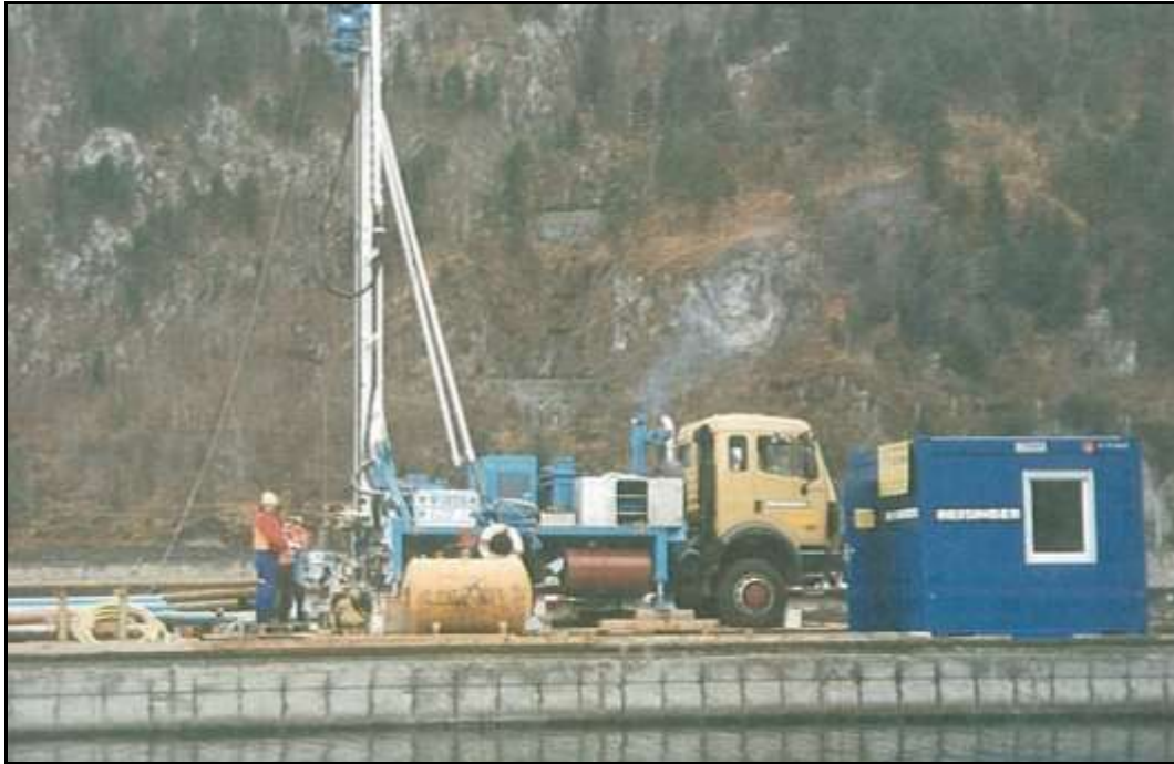
Abb. 2: Bohranlage Wirt Eco 1 auf Ponton montiert verankert an der Bohrstelle im Traunsee
