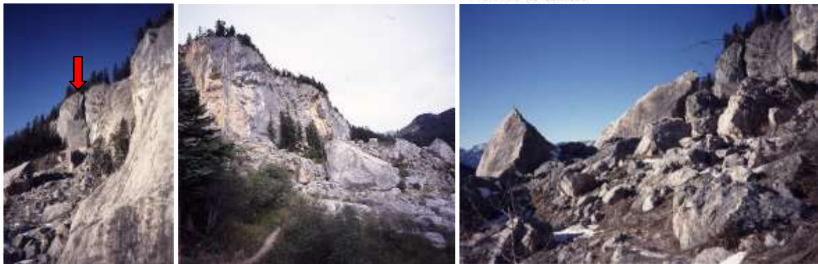
Abb. 13a, b, c: Das Felssturzblockfeld am Fuße der Zwerchwand (offene Kluft, ↓), dessen gewaltige Blöcke heute bereits als Klettergarten verwendet werden (Fotos: J.T. Weidinger 2003).
