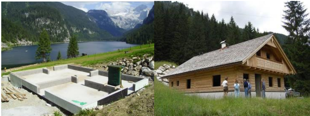
Errichtung Almhütte mit Stall in Blockbauweise und Lärchenschindeldach auf der Seeklausalm – Ersatzbau mit Lawinenschutzwall
