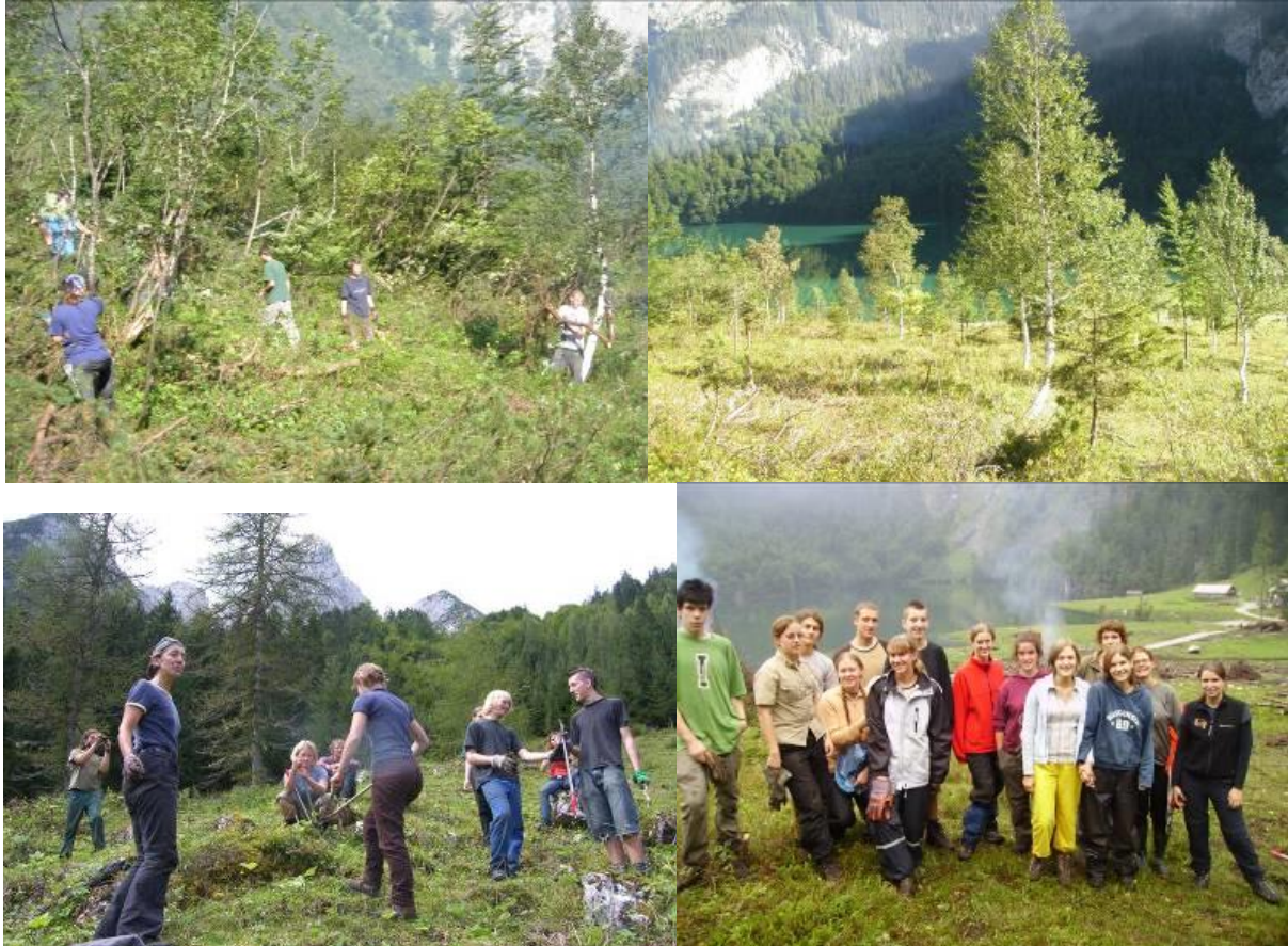
ÖAV- Umweltbaustelle 2007: Schaffung einer Birkenweide am Hinteren Gosausee Aufräumungsarbeiten in Lawinen-Schadflächen mit naturschutzfachlich abgestimmten Weideverbesserungen
