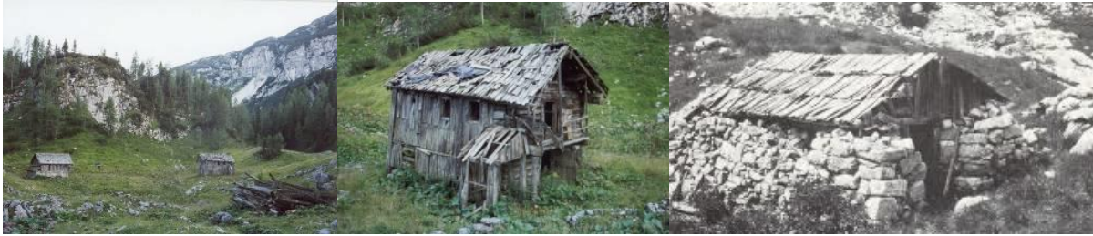
Drei verfallene Almhütten auf der Lahnfriedalm 1999 // Steinhüttel Bärnlackenalm, Foto Stadler 1980
