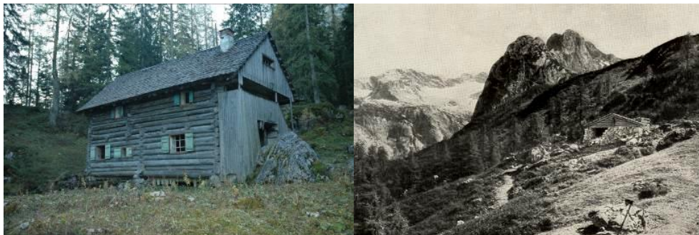
Links: Alte baufällige Doppelhütte Vord. Scharwandalm
