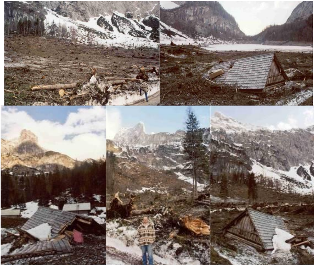
Lawineneignis Hintere Gosauseealm - BROTGRABEN - LAWINE - Feb. 2005 10 ha Waldzerstörung mit 1000 m 3 Lawinenholz, verwüsteter Almboden, zerstörte Jagdhütte (Baujahr 1906)
