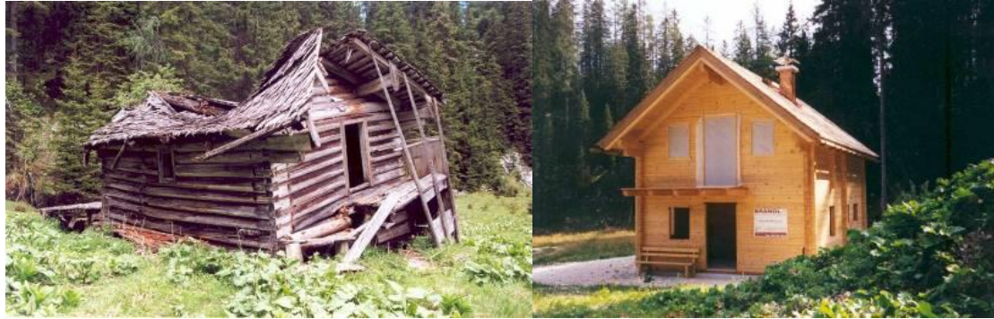
Links: Verfallene Almhütte auf der Hallstätter Grubalm (1250m)
