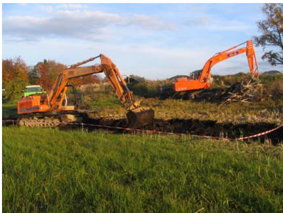
Baggereinsatz in Eugendorf
