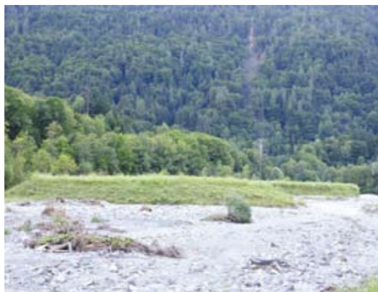
▲ Das Retentionsbecken nach dem Hochwasserereignis am 02.08.2013, G.N.
