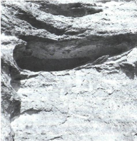
Bild 3: Ausgang einer mit Kalkkrusten ausgestatteten Wandnische. Auch die Außenwände sind von abblätternden Krusten überzogen.
