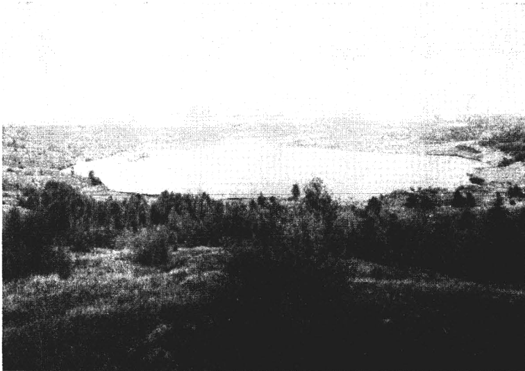
Abb. 4. Verspülung von Feststoffabprodukten (Ascheverspülung) sowie von Abraum- und Mittelmassen aus einem benachbarten Kohlebaufeld zur Auffüllung eines Tagebaurestloches. Im Bild rechts Anlage von Spülkippen zur Böschungsstabilisierung der Südböschung des ehemaligen Tagebaues Großkayna/Geiseltal. Im Vordergrund sogenannte „Girlandentrutschung“ an der Ostflanke des Kippendamms Großkayna
