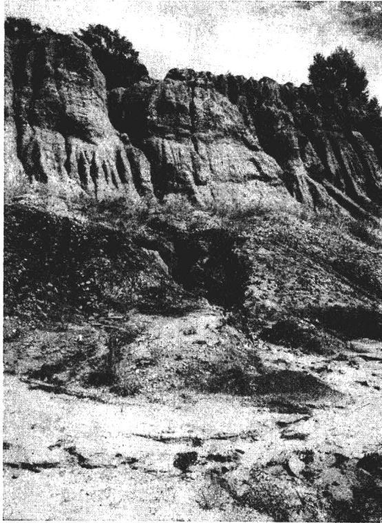
Abb. 9. Durch Wassererosion völlig zerstörte Kippenböschung mit „Badland-Charakter“ an der Ostböschung des ehemaligen Tagebaues Braunsbedra. Im Vordergrund Sedimentakkumulation des abgespülten Materials aus den oberhalb liegenden Erosionsrinnensystemen
