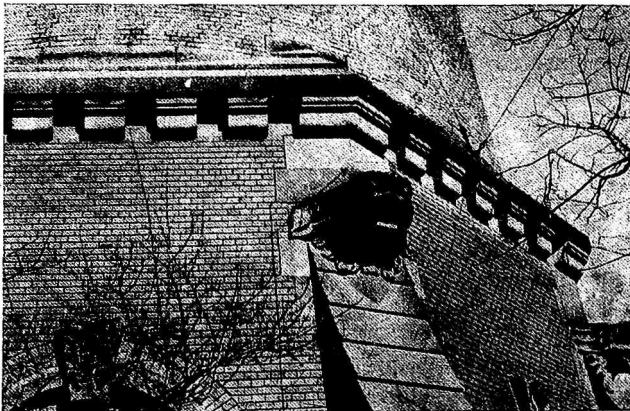
Abb. 11 Wasserturm am Platz der Thälmann-Pioniere. Die Steinmetzarbeiten sind aus Rochlitzer Porphyrtuff.
