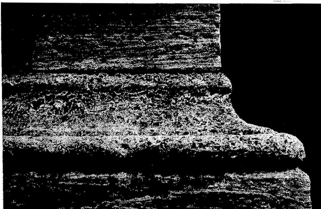
Abb. 9. Freyburger Schaumkalk Teil eines Strebe- pfeilers, der seit über 550 Jahren dem Regen ausgesetzt ist
