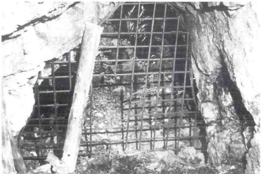
Abb. 5: Einfache Eisengitter sind leicht aufzusägen. Foto: U. Fricke (Bad Harzburg)
