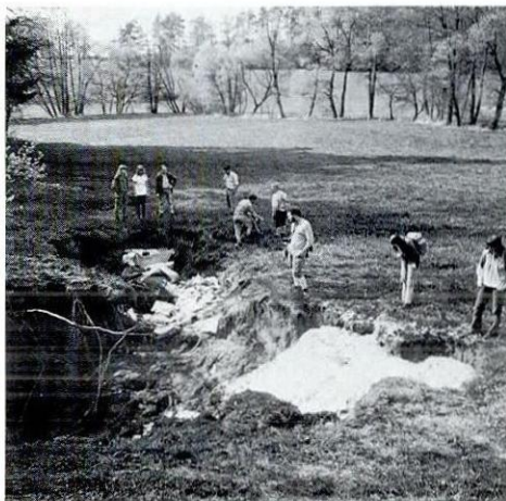
Abb. 3: Müllschlucker-Erdfall, Höhlenkataster Nr. A 304, bei Saaß, mit Müllablagerungen. Ansicht von Südosten. Zustand am 6. Mai 1984.
