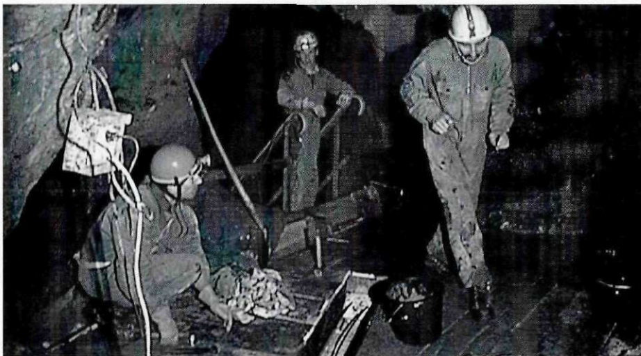
Abb. 5: Arbeiten von Mitarbeitern in der Höhle: Erneuerung der Plattform unter dem „Niagarafall“, einer bedeutenden Sinterbildung. Foto: H. Ilming (Brunn)
