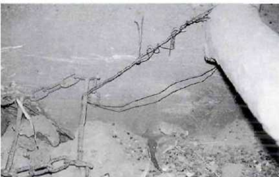
Abb. 8: Schachtmund in der Eingangshalle. Der Schacht ist mit einer korrodierten Kettenfahrt „erschlossen“, die frei hängend in die Tiefe führt. Als Anker dienen ein in einer Spalte querstehender trockener Ast und ein 40 cm langes Drahtstück.
