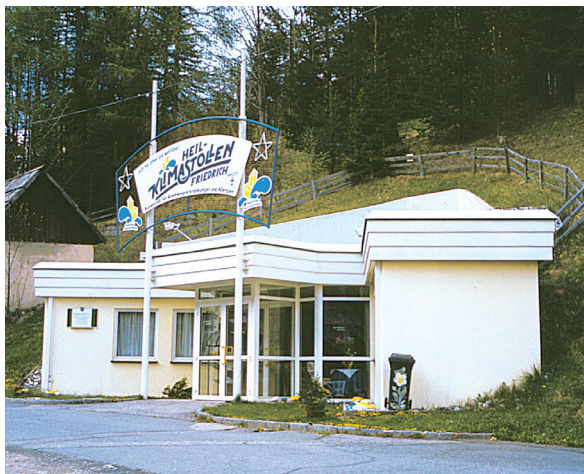
Abb. 2: Betriebsgebäude des Friedrich-Stollens in Bad Bleiberg (Kärnten) Foto: Hubert Trimmel
