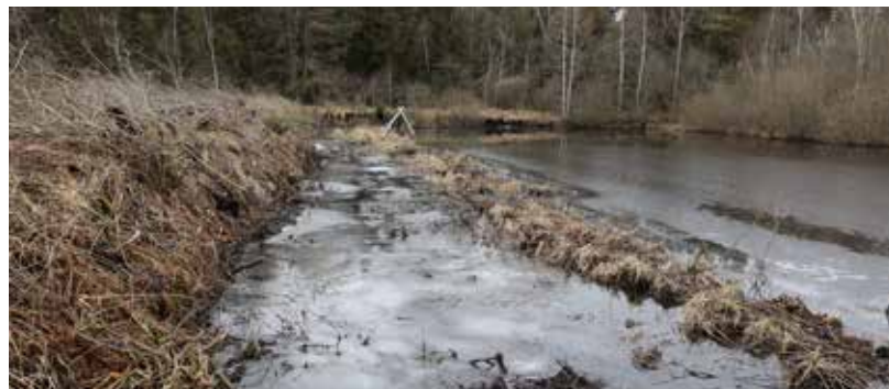
In einem entbuschten Torfstichteichen werden Sumpfflächen für die Bekassine angelegt und künftig dauerhaft offen gehalten.
