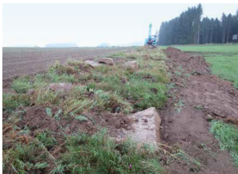
Verlegung der Rasensoden und des Steinmaterials des ehemaligen Rains am neuen Standort 2019.
