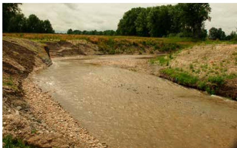
Durch die Renaturierung der Antiesen bei Forchtenau (Gem. Auroldmünster) wurden ökologisch wertvolle Uferstrukturen und Feuchtbiopte geschaffen.
