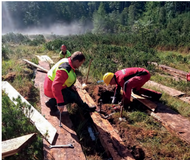
Spundwändebau im Laudachmoor.
