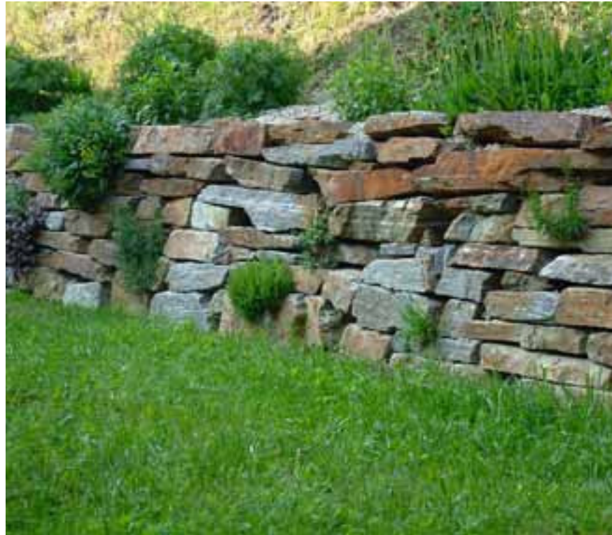
Trockensteinmauer aus Gneis. Foto: Luger
