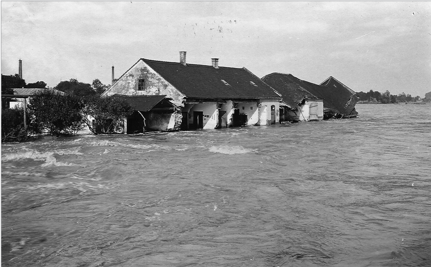
Abb. 7: Die zerstörten „Bürstinger-Häuser“ (Traungasse 25-27) im September 1899 (Wels, Stadtarchiv, JA2-30). Abgesehen von den dramatischen Schäden wird durch die kurze Verschlusszeit besonders die Wucht der Fluten zusätzlich betont.
