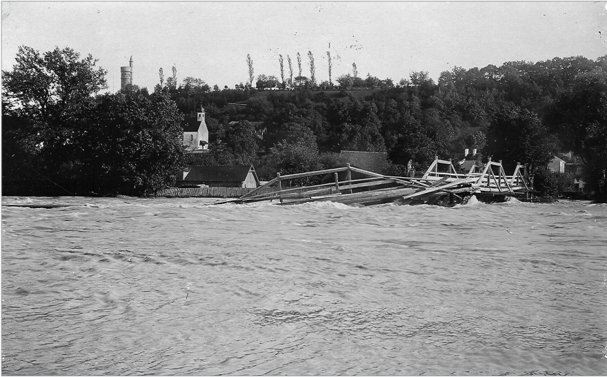
Abb. 11: Die völlig zerstörte Notbrücke über die Traun Mitte September 1899, Blick gegen Aigen (Wels, Stadtarchiv, JA2-42). Nach den Zerstörungen von 1897 wurde die hölzerne Traunbrücke nur mehr notdürftig saniert, da der Plan für eine Stein-Stahl-Konstruktion immer konkreter wurde. Diese wurde schließlich erst nach 1899 realisiert und 1901 fertig gestellt.
