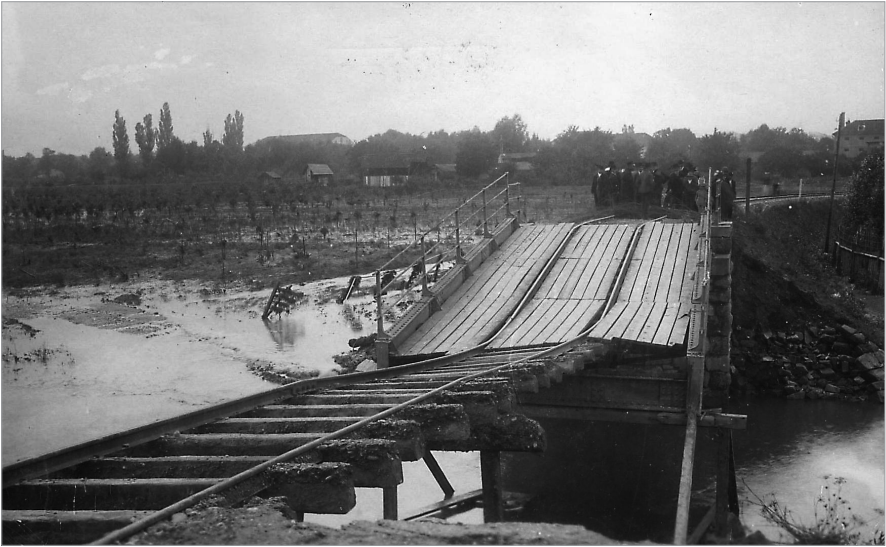
Abb. 9: Die eingeknickte Eisenbahnbrücke gegen Norden Anfang August 1897 (Wels, Stadtarchiv, JA1-10). Zerstörte Infrastruktur gehört zu den häufigsten Sujets der Naturkatastrophenfotographie. Verbogene Eisenbahnschienen können die Naturgewalt besonders deutlich machen. Unklar bleibt, ob es sich bei der Menschengruppe um Arbeiter handelt, die die Schäden beseitigen sollen, oder um eine Delegation bei der Schadensaufnahme.
