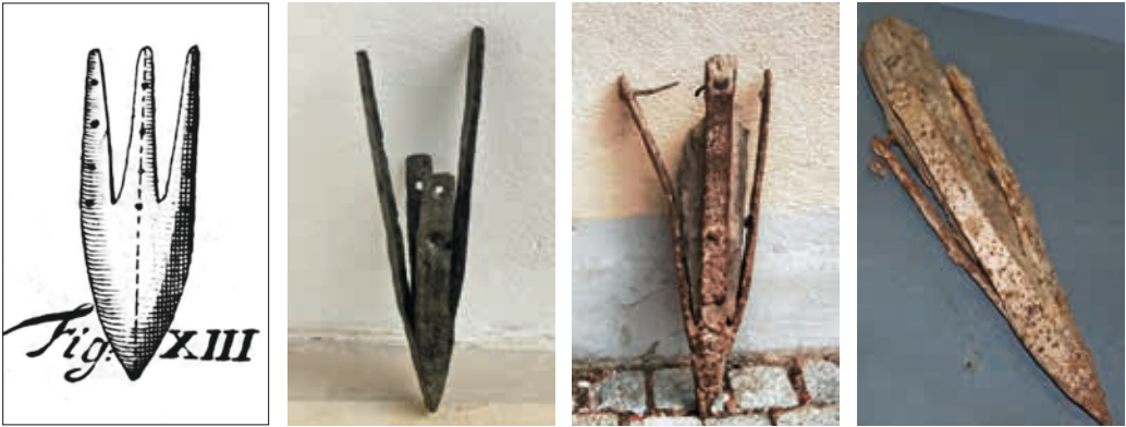
Abb. 15 (lins): Eisenschuh für Piloten nach Leupold, Theatrum pontificiale , Tafel IV
