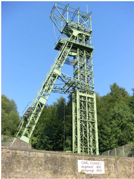
Abb. 16: Fördergerüst des Schachtes I der ehemaligen Zeche Carl Funke (T. KASIELKE).
