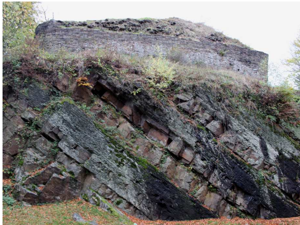
Abb. 9: Kaisberg-Sandstein im Burggraben der Isenburg. Die massiven Sandsteinbänke werden von Lagen aus Tonstein getrennt. Die Schichten fallen nach Südosten ein (T. GREILICH).
