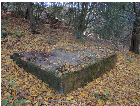
Abb. 15: Mit einem Betondeckel gesicherter Schacht der Zeche Dickebaeckerbank (T. KASIELKE).
