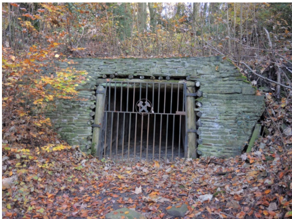
Abb. 13: Rekonstruiertes Stollenmundloch der Zeche Dickebaeckerbank (T. KASIELKE).
