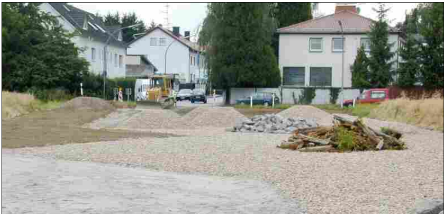
Abbildung 19: Anlage eines Trockenbiotops für die „Blaüflügelige Ödlandschrecke“ ( Oedipoda caerulescens ; LINNAEUS, 1758) nach Abtrag des humosen Oberbodens und Auftrag von nicht standorttypischen Material in Wiesbaden; Foto: T. Vorderbrügge.
