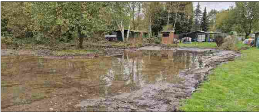
Abbildung 20: Anlage eines Kleingewässers nach Abtrag des Oberbodens; Foto: Ing. Büro N. Feldwisch.
