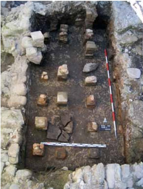
Abb. 13: Innsbruck – Wilten, Graßmayrkreuzung. Westhälfte des mittleren Raumes des römischen Bades mit den freigelegten Hypokaustpfeilern der Unterbodenheizung, Ansicht von Süden
