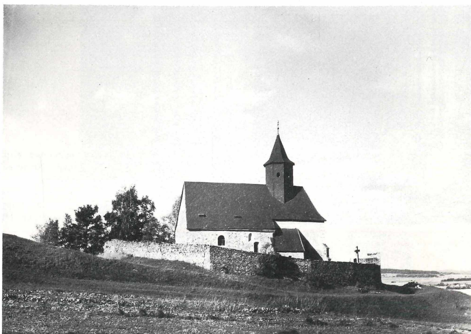
Abb. 13: Kleinzwettl, Filialkirche hl. Jakob d. Ä. Gesamtansicht von Süden, mit Ringwall, Graben und Wehrmauer des Friedhofs. (Foto: Csaba Tarcsay).
