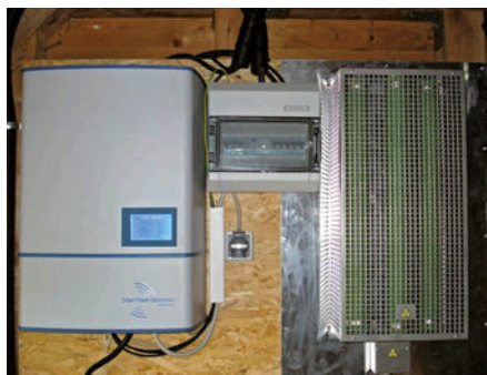
KWEA mit Steuerungselektronik auf dem Grundstück eines Einfamilienhauses im Hunsrück Fotos: Schalimow 2014
