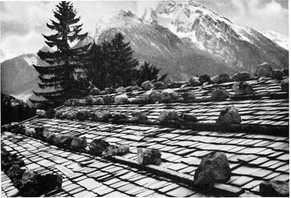
Bild 26: Legschindeldach
