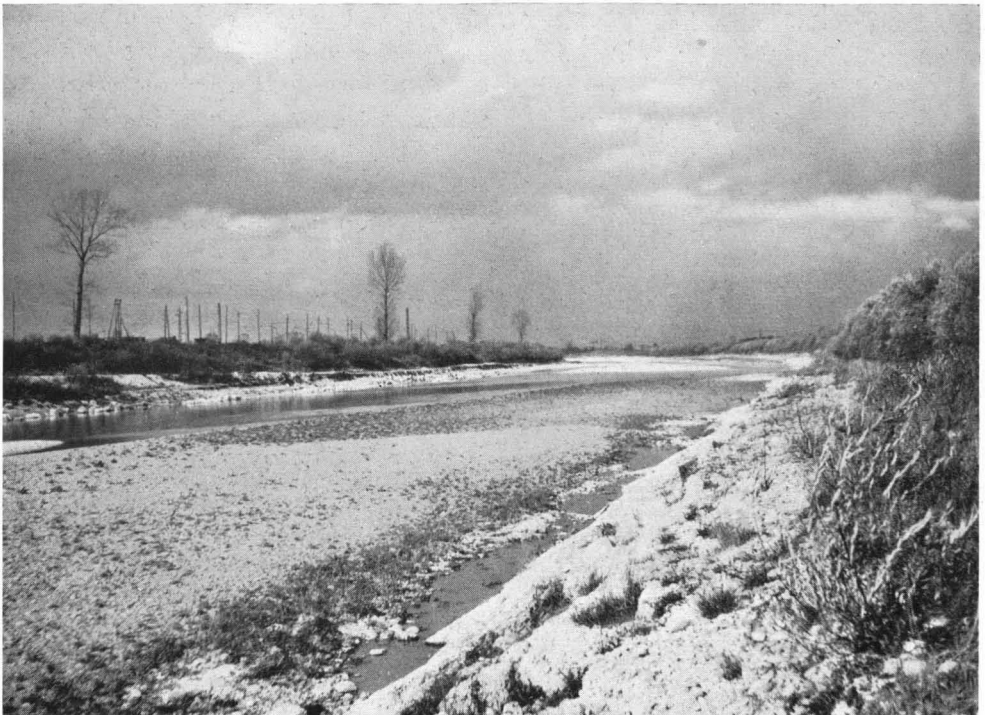
Die Kanalrinne des Lechs bei Gablingen
