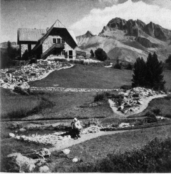
Laboratoriumsgebäude (von Süden) mit einem Teil der Gartenanlagen.
