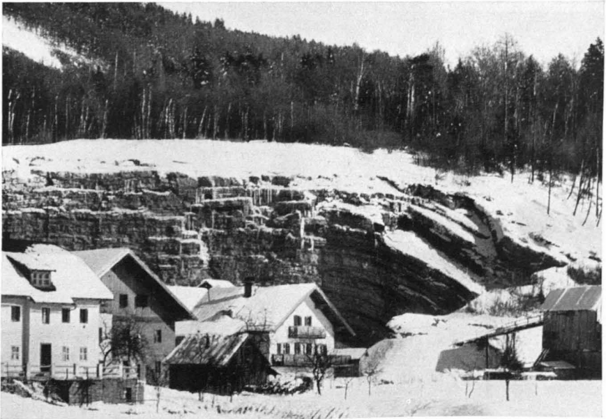
Abb. 2 Oberalm. Die zementgrauen, grob- und dünnbankten Schichten mit ihren kennzeichnenden Hornsteinschnüren und -knollen riefen eine ausgedehnte Steinindustrie hervor. Das verwitterungsbeständige Material wird zu Bauten viel verwendet. Typisch hier das bogenförmige Absinken der Schichten (Flexur), die hier unter die eiszeitlichen Ausfüllungen des Stammbeckens hinabtauchen.
