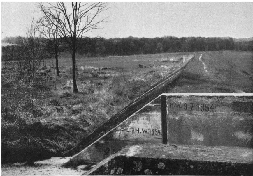
Abb. 20 Ettenau. Von Ostermiething ab bis Radegund faßt ein flußseitig mit Zementplatten ausgekleideter Hochwasserdamm noch einen Großteil des Auenwaldes ein. Das für Alpenvorlandflüsse so kennzeichnend rasche Anschwellen von Hochwassern wird hier am Durchlaß ersichtlich. Im Sommer 1954 durchbrachen oberhalb Radegund die Hochwasser den Damm und verwüsteten das Wirtschaftsland.
