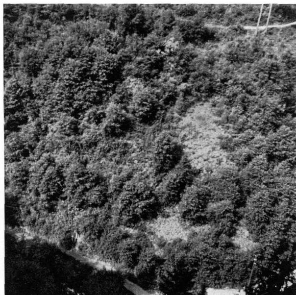
*Abb. 8 und 9 Felssturz in Wattens (Unterinntal): Eine langsam abgleitende Quarzphyllit-scholle hatte ein darunterliegendes E-Werk zerstört und den Aufstau des Wattenbaches befürchten lassen. Deshalb wurde der Hang abgeböschet und begrünt. Oberes Bild während der Abböschungsarbeiten 1951, unteres Bild Zustand 1960, bei dem die künstlichen Begrünungsmaßnahmen überhaupt nicht mehr erkennbar sind. Vogelschaubild von einer gegenüberliegenden Felswand aufgenommen*
