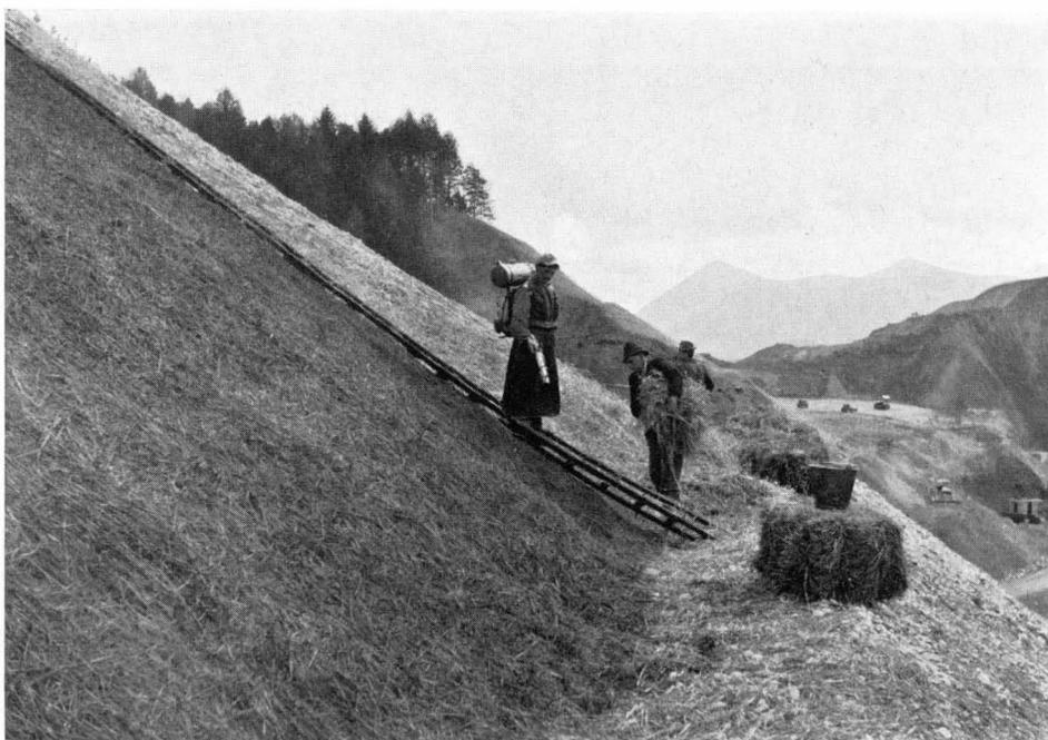
*Abb. 3 Begrünung des 150 m hohen Abrnbergeinschnittes an der Brenner-Autobahn mit Hilfe der „Saat auf Strobedeckschicht“. Die hier in Arbeit befindliche Böschung wurde bereits zwei Monate später gemäht*
