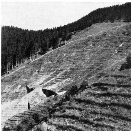
*Abb. 1 und 2 Ein Teilstück des Filpritter Tobels (Gallinabach bei Frastanz in Vorarlberg) bei Beginn der ersten Begrünungsarbeiten mit Cordons auf Reisigunterlage 1952 (links) und 3 Jahre später bereits völlig gesichert*
