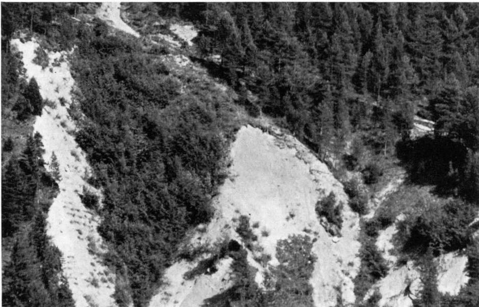
*Abb. 6 und 7 Sticherrippe bei Hochzirl im Oberinntal, 1000 m ü. d. M. Oberes Bild bei Beginn der Arbeiten 1950. Darunter der Zustand 1960. Für Versuchszwecke wurde nur eine Teilfläche begrünt. Im rechten Runst begnügte man sich mit einer Sicherung der Sohle gegen weitere Eintiefung*
