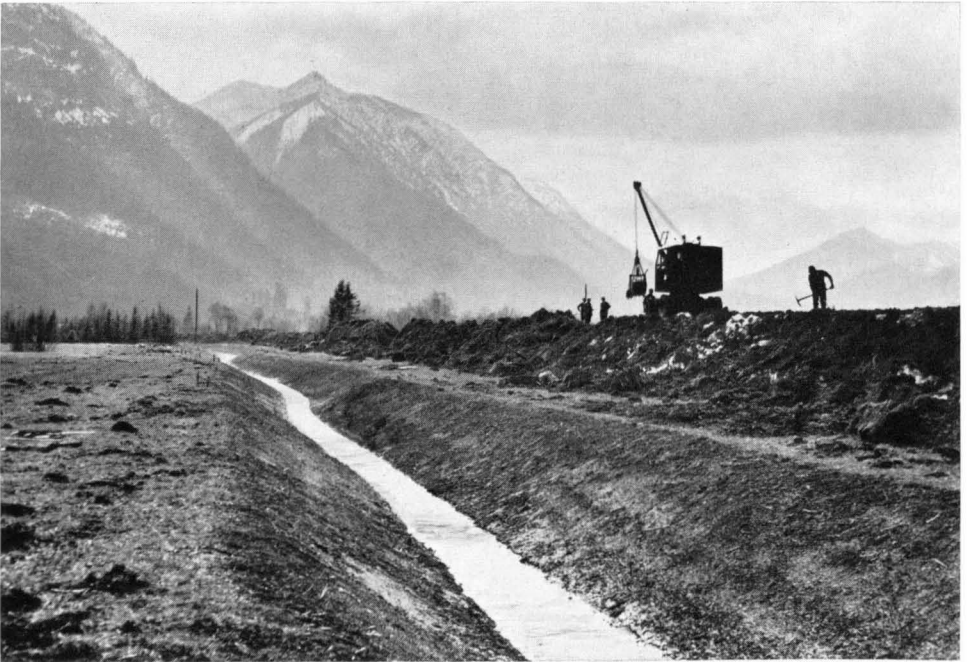
Bild 16 Instandsetzungsarbeiten an der regulierten oberen Ammer im berühmten Weidmoos bei Ettal in Oberbayern (1963). Durch Verhandlungen konnte die beabsichtigte Entwässerung von Teilen dieses wasserwirtschaftlich wie floristisch berühmten Moooses verhindert werden. Hier befindet sich der größte Standort des Eiszeitrelikts König Karls-Zepter in Mitteleuropa.
