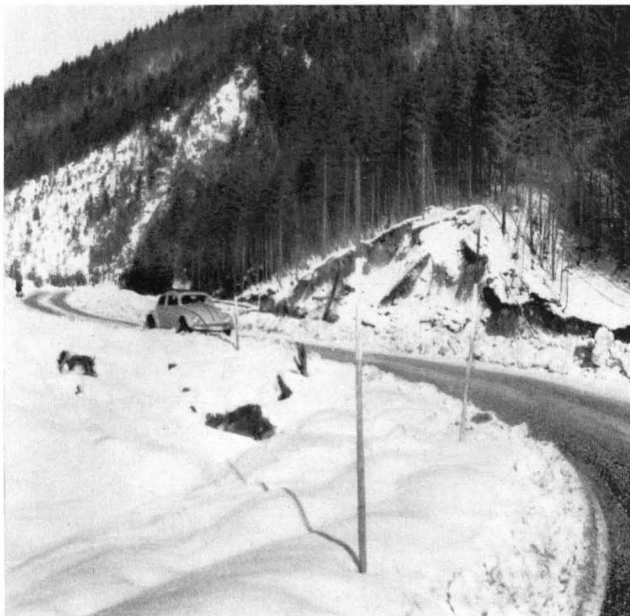
Abb. 7 Straße über die Mure. Dahinter Gehängeanriß am Sonnberg-Fuß
