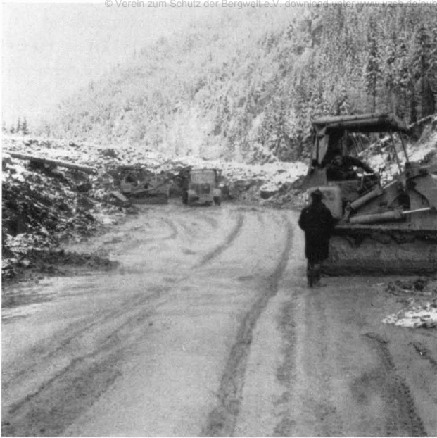
Abb. 5 Versuche, die vermurte Bundesstraße freizulegen, scheitern am ständigen Nachfließen des Murstromes
