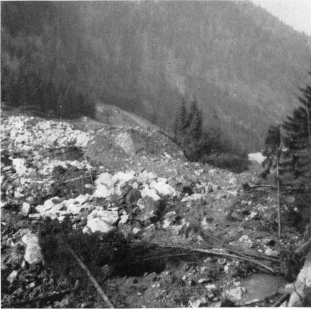
Abb. 1 Hier begrub der Bergsturz das alte „Mentl“-Gut und das neue Eigenheim Kobl, überfuhr die Bundesstraße und drängte den Bach an den Fuß des Sonnberges (Stauseebildung)
