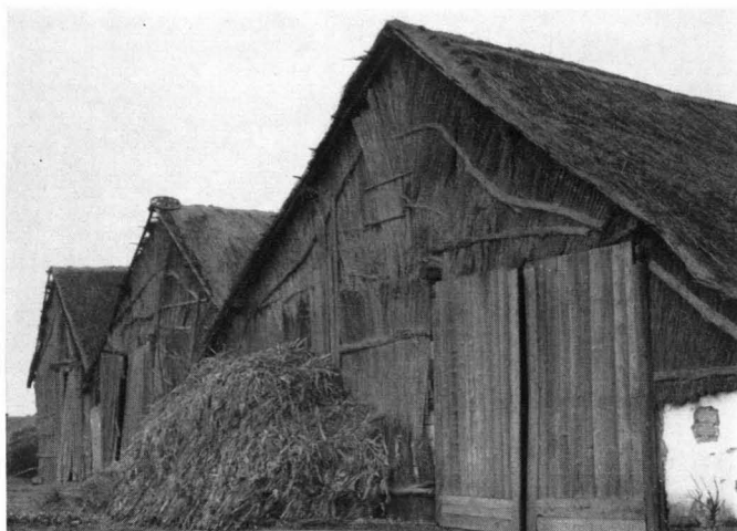
Abb. 16 Früher war Schilf ein charakte- ristisches Baumaterial der Seegegend. Schilf- scheunen in Apetlon
