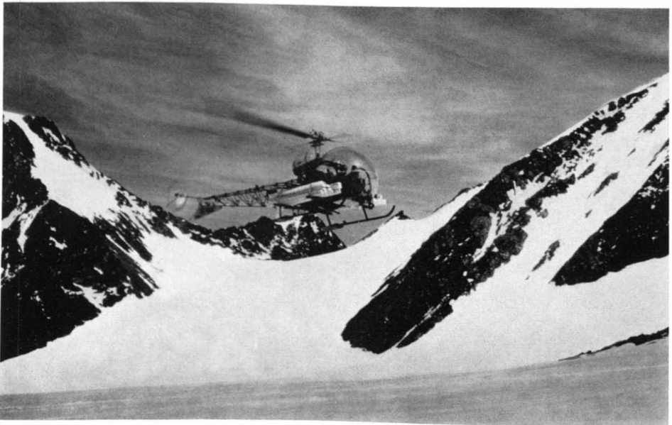
Abb. 7 Ein Hubschrauber der Flugrettungsstelle Innsbruck bringt Baumaterial zur Errichtung der Laboratoriumsbaracke auf den Hohen Nebelkogel (3211 m)
