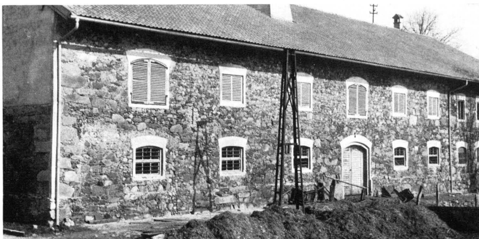
Straß bei Wasserburg: Hausbau aus Findlingen
