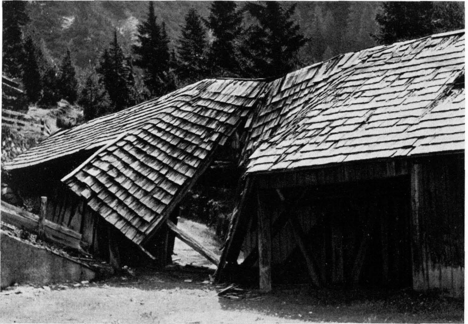
Abb. 11 Kopfstation der Seilbahn am Unna-Stollen
