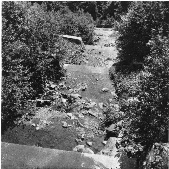
Abb. 7 Korrigierter Wildbach mit natürlicher Einkleidung. Rotmoosgraben bei Giswil.
