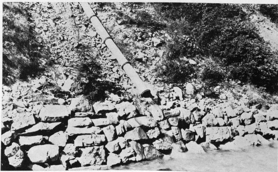
Abb. 34 Technische Verbauung und künstliche Begrünung an der Halbammer.
