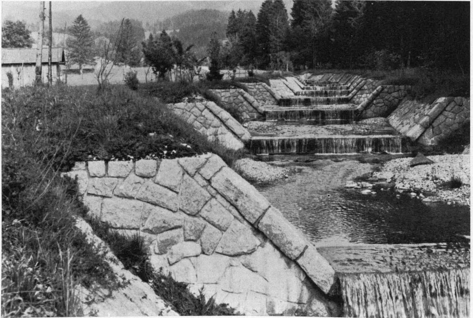
Abb. 31 Enge Leine bei Unterammerngau, Verbauung.
