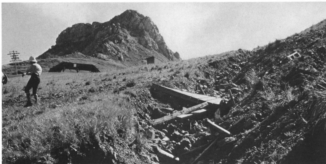
Bild 15 Das Bild zeigt eine Tiefenerosion mit einer Eintiefung von bis zu 1,60 m. Das abfließende Wasser hat hier einen Drainagegraben eingetieft. Vom Oberhang (rechts) wird ständig Material nachgeführt, was zu einer zunehmenden Instabilisierung des angrenzenden Hangfußes und zu einer Verbreiterung des Grabens führt. Auffallend auch die dadurch entstehende deutliche Asymmetrie des Grabenprofils. Im Bildhintergrund der Kanzelwandgipfel und davor die Bergstation von Lift VII. (Bierenwangpiste)
