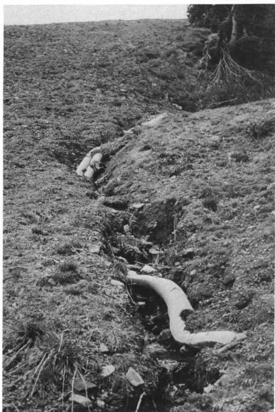
Bild 15 Das Bild zeigt eine Tiefenerosion mit einer Eintiefung von bis zu 1,60 m. Das abfließende Wasser hat hier einen Drainagegraben eingetieft. Vom Oberhang (rechts) wird ständig Material nachgeführt, was zu einer zunehmenden Instabilisierung des angrenzenden Hangfußes und zu einer Verbreiterung des Grabens führt. Auffallend auch die dadurch entstehende deutliche Asymmetrie des Grabenprofils. Im Bildhintergrund der Kanzelwandgipfel und davor die Bergstation von Lift VII. (Bierenwangpiste)
