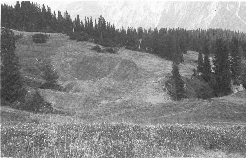
Bild 4 Das Bild zeigt eine große Tobelerbauung im Zusammenhang mit einer Vollplanierung im Bereich der Walsergundpiste, im Hintergrund ein Teil des Liftes IV. Nahezu der gesamte Bildausschnitt vom Vordergrund bis zu den Latschenbeständen von Lift IV ist vollplaniert und vereinzelt mit Drainagegräben durchzogen. Die nahezu vegetationslose Fläche kennzeichnet den Aufschüttungsbereich der Tobelerbauung, im Bildvordergrund ein Beispiel für typische Vegetation von wieder-begrüntem Flächen (Klee).
