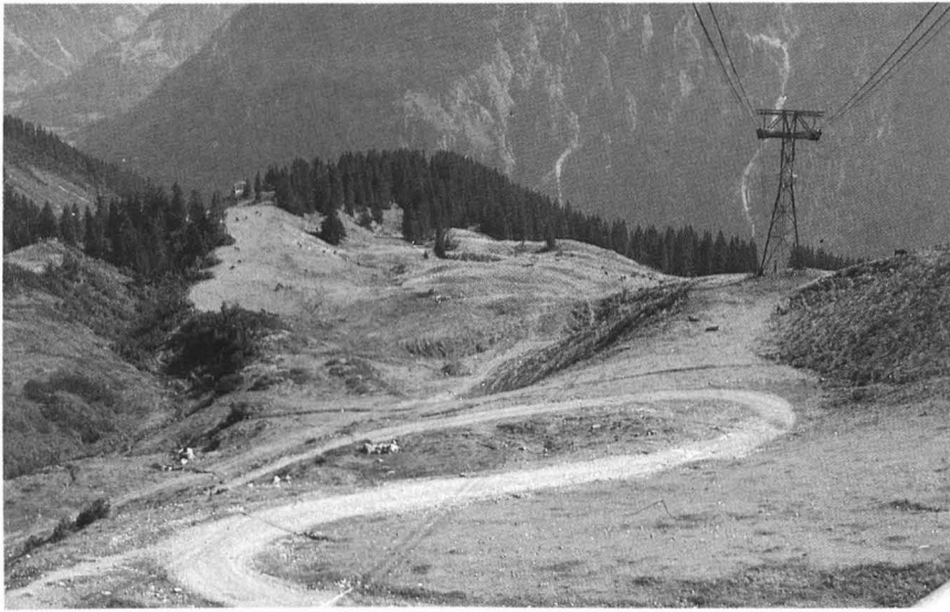
Bild 3 Das Bild zeigt die Situation direkt östlich unterhalb der Fellhornbahn-Bergstation. Am linken Bildrand der eingeschnittene Kuchenbach. Das Bild verdeutlicht die verschiedenen Arten der Geländekorrektur : vom Aufnahmestandpunkt in Richtung Seilbahnmast und im linken Bilddrittel die mit Kühen bestandene Fläche ist Vollplanierung , weite Bereiche zwischen diesen beiden Flächen sind durch Teilplanierung verändert worden; im Bereich der linken unteren Bildhälfte bis zur geschlossenen Latschengruppe rechts des Kuchenbaches haben Einzelkorrekturen stattgefunden. Korrigierte Flächen unterscheiden sich auch hier von unkorrigierten Flächen deutlich im Erscheinungsbild der Vegetation.
