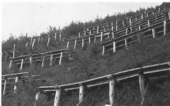
Bild 9 Aufforstung im Schutz einer temporären Lawinerverbauung. Landesamt für Wasserwirtschaft
