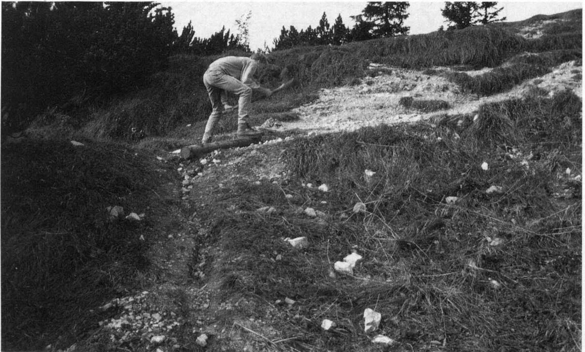
Abb. 7: Erosionsansatz unterhalb einer Wasserauskehre.
