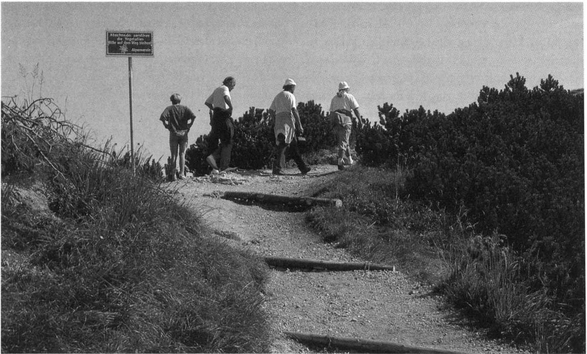
Abb. 2: Am Weg eingebaute Wasserauskehren aus rohen Nadelholzstangen.
