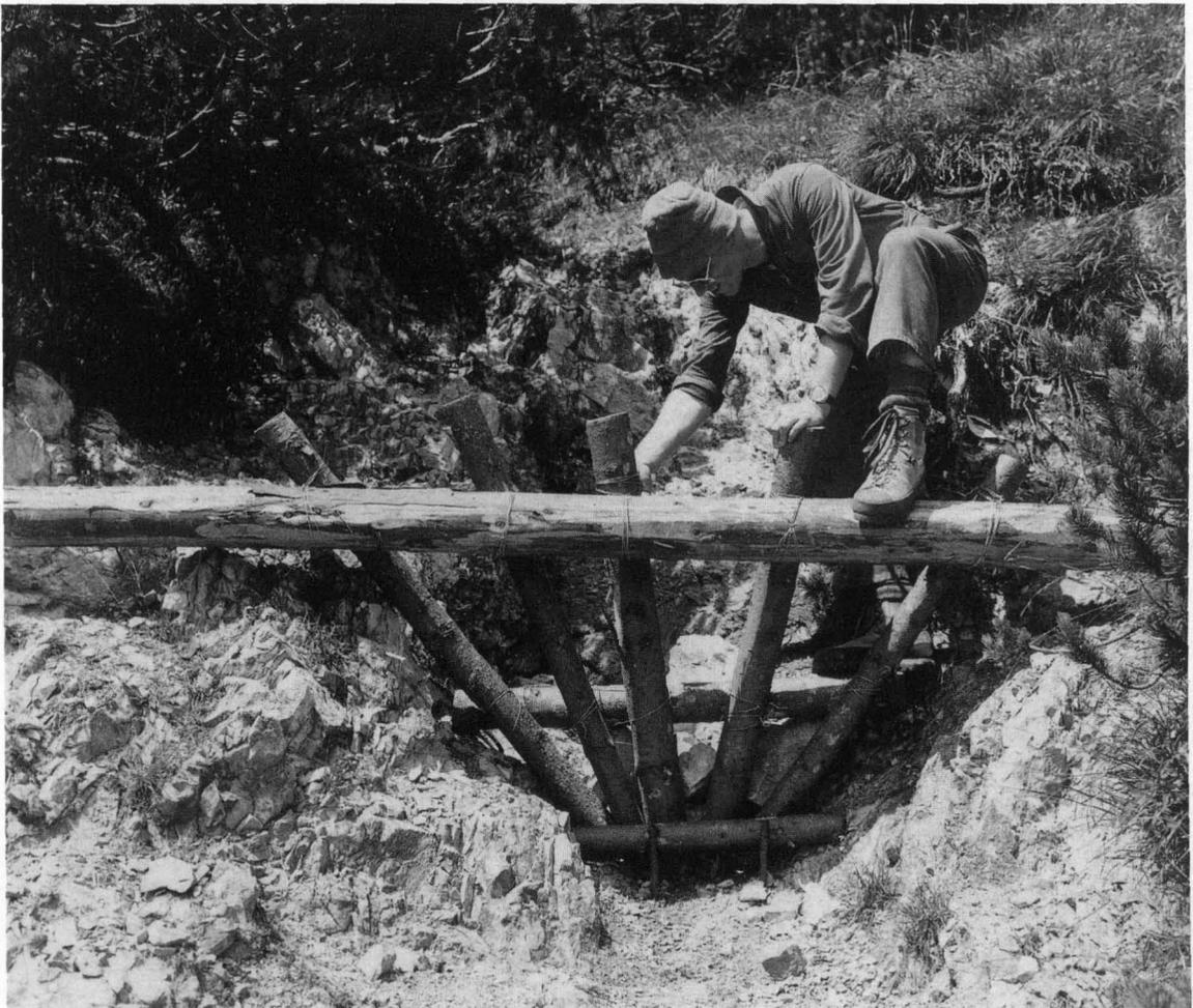
Abb. 8: Beispiel einer Erosionsrinne unmittelbar nach dem Einbau eines Holzrechen im August 1988.
