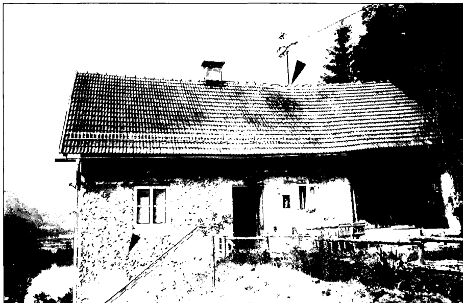
Abb. 10. Gebäudeschäden (Knick im Dach, Risse in den Wänden) am Haus Preliebl Nummer 1 verursacht durch Hangkriechen.
