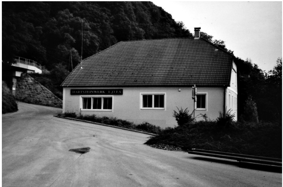
Abb. 3. Das Verwaltungsgebäude des Hartsteinwerkes Loja am Betriebsparkplatz. Links im Bild die Unterführung des Gleiskörpers der Wachaubahn.
