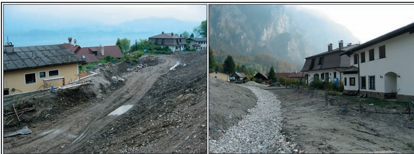
Abb. 14. In Anlage befindliche (links) und fertige Drainageschlitzte (rechts) hinter den Häusern auf dem 1910er bzw. 2008er Erdstrom des Gschliefgrabens. Die blauen Rohrstützen sind Brunnen bis auf die aktive Gleitfläche in ca. 20 m Tiefe, die allmählich zum Übergang von einem Gleit- in einen Kriechprozess führten und die Rutschung zum Stoppen brachten (freundl. münd. Mitteilung von Prof. Dr. R. POISEL, TU-Wien).
