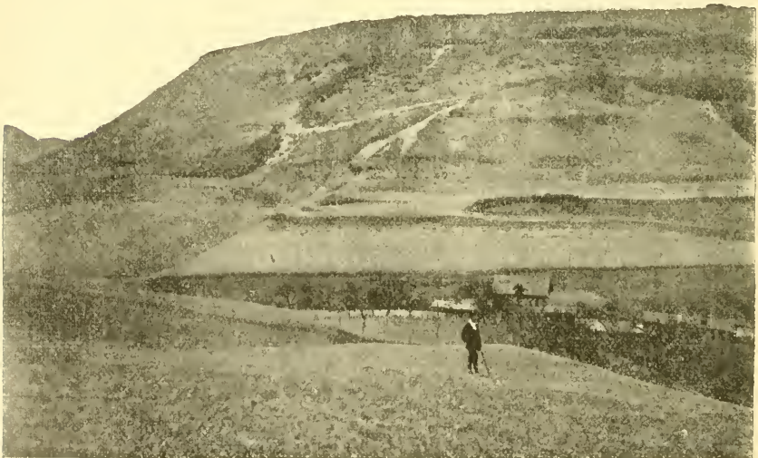
Gesamtansicht des Galgenberges mit Bahnhof Weissenstein im Vordergrund.
